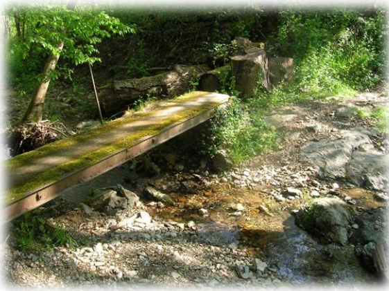
La passerelle de La Broie
