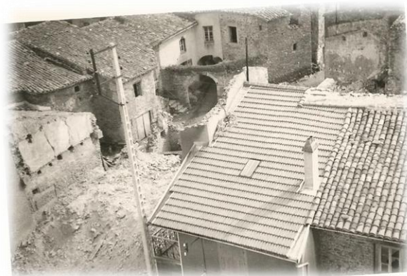
Vue depuis le toit de l'église et la rue de la Forge pendant les travaux
