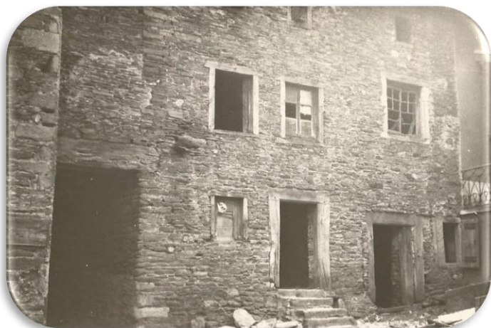
La maison démolie pour l'ouverture de la rue de la Forge. A droite un balcon.
