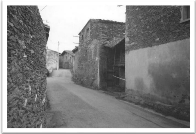
Rue du village avant la démolition de la maison Perret
