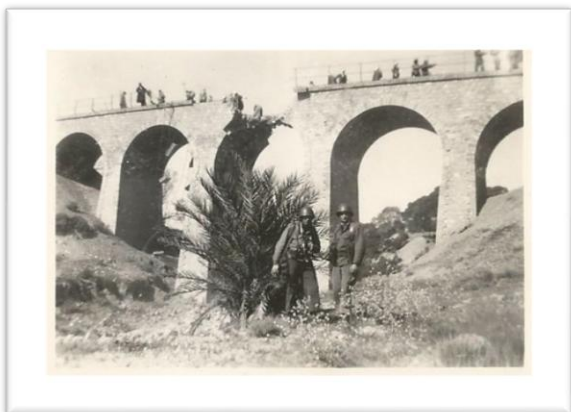
Le viaduc après le passage
