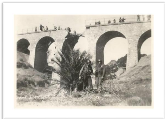
Le viaduc après le passage du train sur une mine
