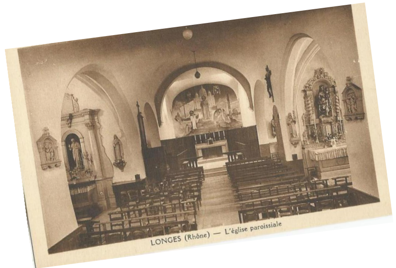
Après réfection suite à l'incendie
