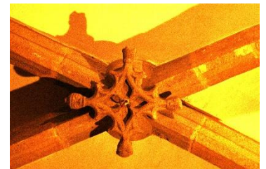
La voûte et la clé de voûte
