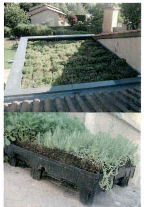
Exemple de toiture-terrasse végétalisée et bacs pré-cultivés
