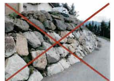
Exemple d'enrochements de type cyclopéen
