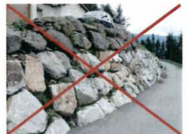
Exemple d'enrochements de type cyclopéen
