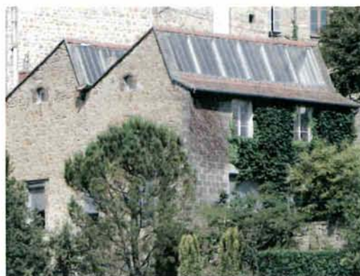
Exemple de toiture en Shed
