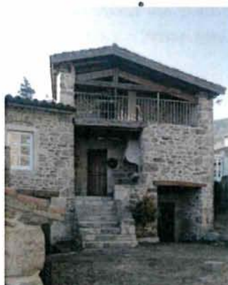
Exemple de débord de toiture
